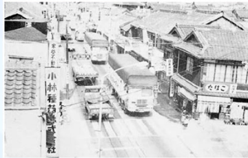
バイパス整備前の加古川市内
