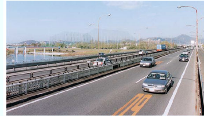
4車線化が完成した新加古川大橋
