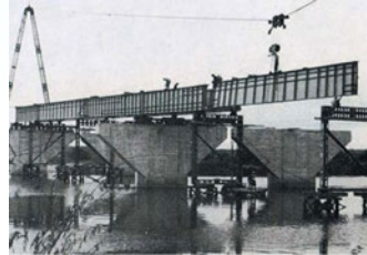
新加古川大橋架設状況
