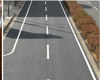
施工イメージ (切削オーバーレイ工)
