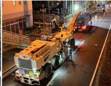
施工イメージ (路盤打換工)
