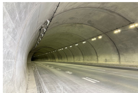
にしわかきた 西脇北バイパストンネル照明 LED 化
