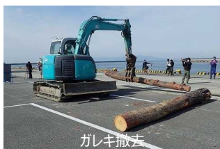
道路啓開訓練（イメージ）
