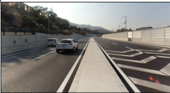
国道176号名塩道路（三田方面を望む）
