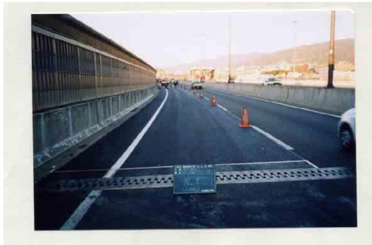
写真2 舗装補修完了後
