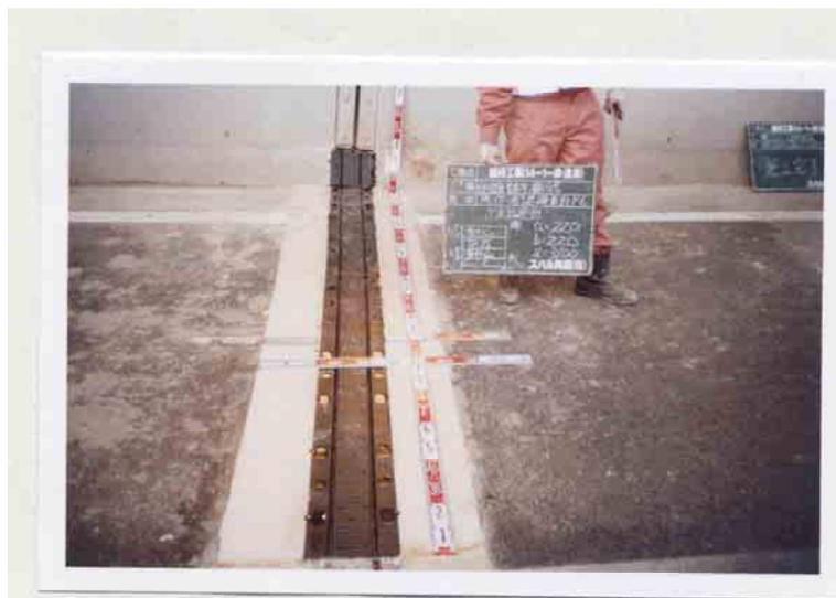
写真3 ゴム伸縮継手補修完了後
