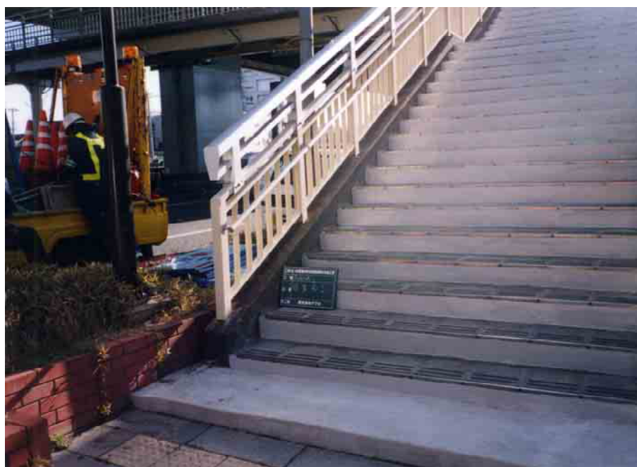
写真 8 高欄の嵩上げ（東本町歩道橋）
