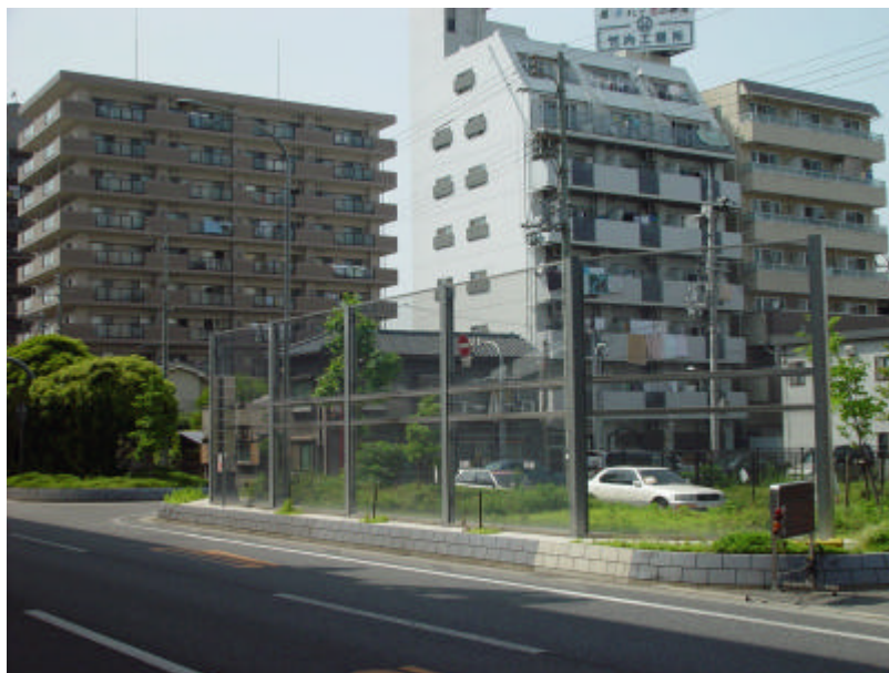
写真3 遮音壁の設置状況（尼崎市西本町3丁目）
