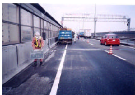
写真1 舗装補修完了後
