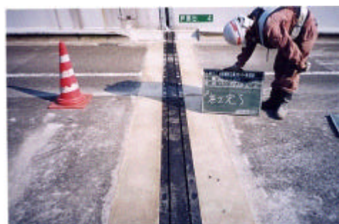
写真2 ゴム伸縮継ぎ手補修完了後
