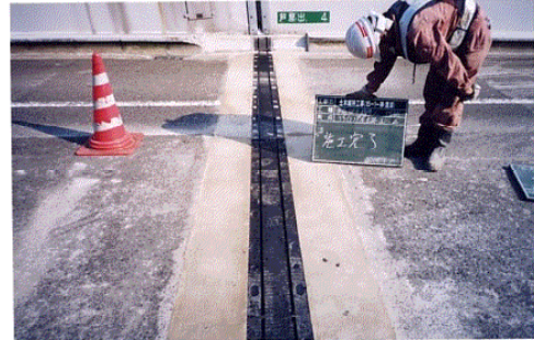
写真2 ゴム伸縮継ぎ手補修完了後
