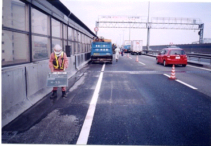
写真1 舗装補修完了後
