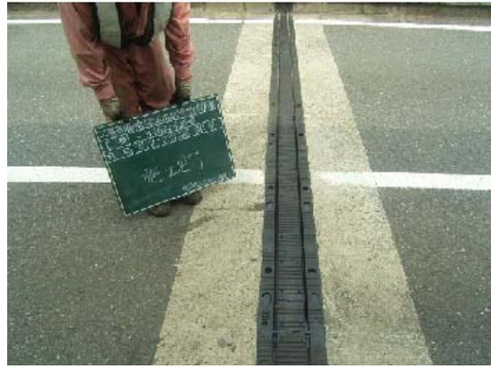
写真2 ゴム伸縮継ぎ手補修完了後
