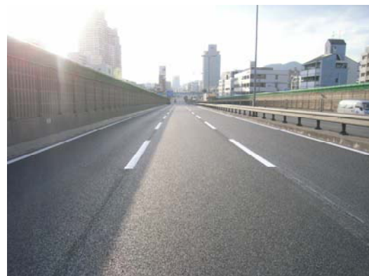
写真2 岩屋高架橋(下り)完成後
