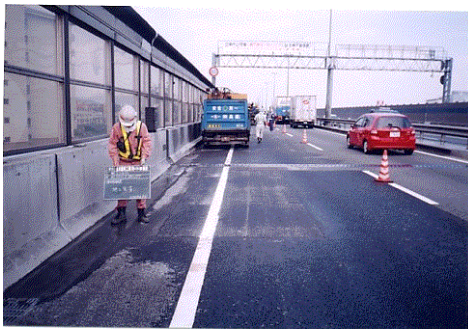
写真3 舗装補修完了後
