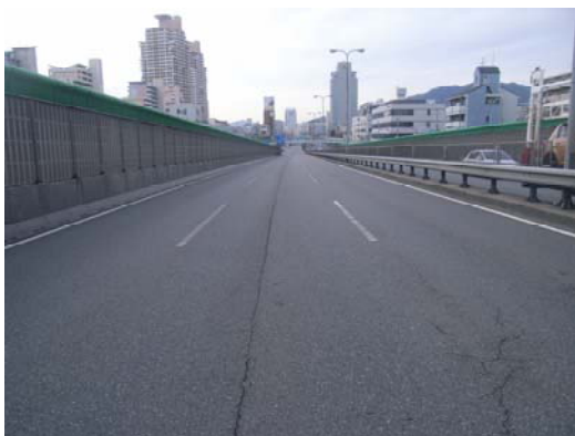
写真1 岩屋高架橋(下り)着工前
