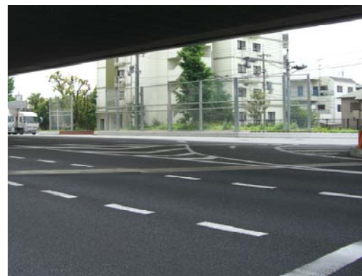
写真6 宮川交差点 完成後
