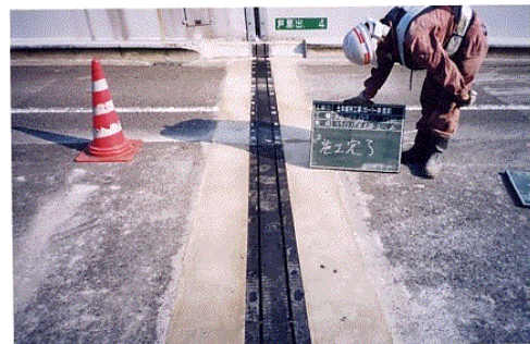
写真4 ゴム伸縮継ぎ手補修完了後
