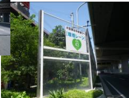
「環境レーン」看板 西行き 尼崎市西本町6
