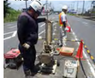
(貫入試験による調査)
