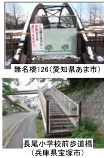
通行止め橋梁
