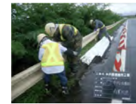
＜防護柵の取替＞
