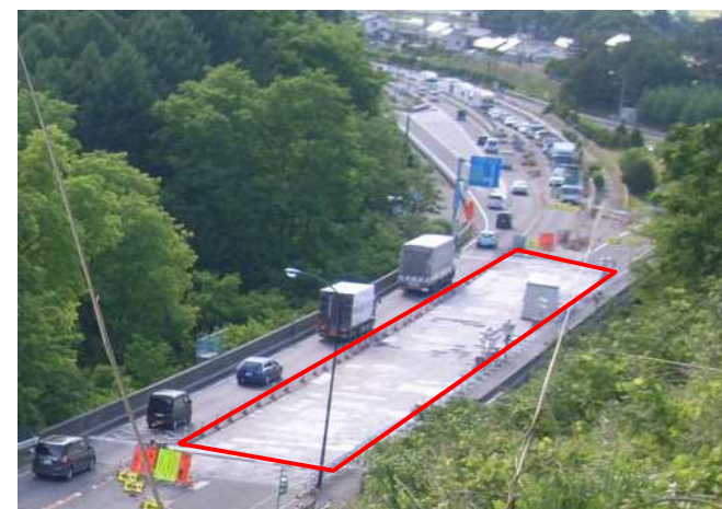
橋梁床版修繕工事の実施に伴う渋滞発生状況
