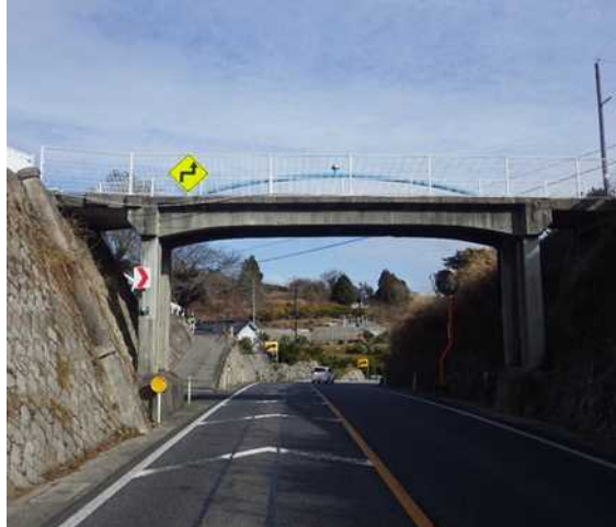
地方管理の跨道橋(未対策)
