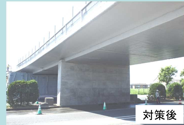
耐震補強の施工例
