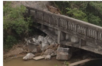
写真-2 平田・小柳線 田中橋
