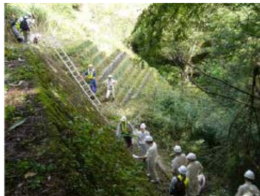
道路防災ドクターによる現地診断
