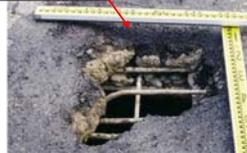
大型車等の重交通が多いと、疲労が蓄積して床版（路面を支える床）が陥没します。床版に穴が開くと、自動車事故の危険があります。
