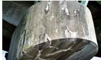
アルカリ骨材反応のメカニズム
