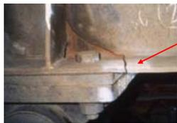
大型車等の重交通が多いと、疲労が蓄積して鋼材に亀裂が発生します。亀裂は板が完全に分断されてしまう損傷なので、落橋につながる損傷になります。
