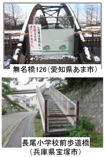
通行止め橋梁
