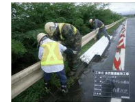
＜防護柵の取替＞
