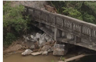
写真-2 平田・小柳線 田中橋
