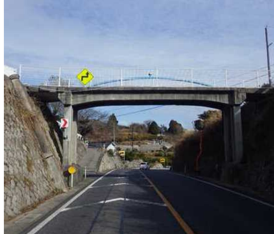
地方管理の跨道橋(未対策)
