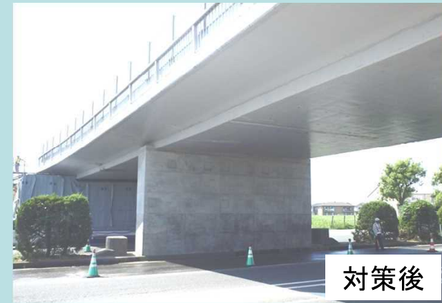
耐震補強の施工例
