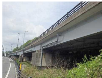
写真-4 阿蘇口大橋 (国道57号)
