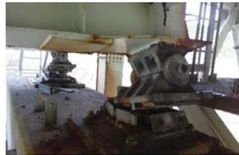
橋梁の支承・主桁の損傷
