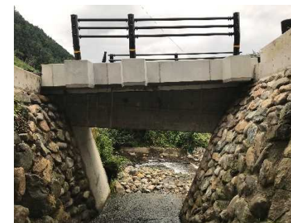
全景(架替完了)
