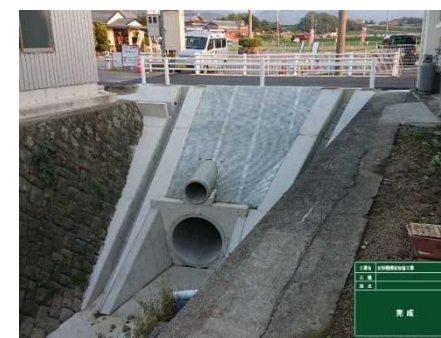
全景(工事完了)
