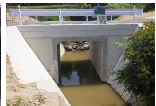
全 景(架替完了)
