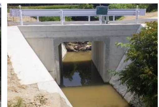
全景(架替完了)
