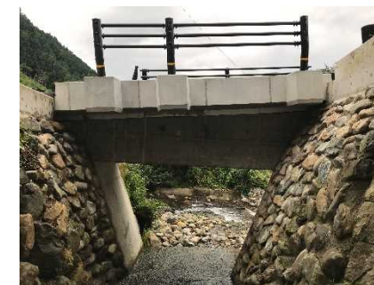
全景(架替完了)
