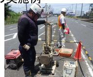
(貫入試験による調査)
