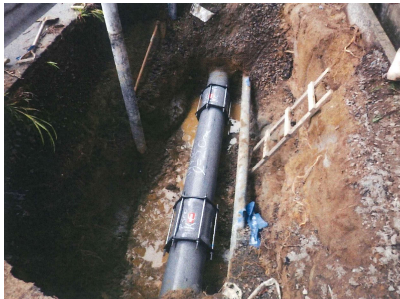
農業用水管補修状況
