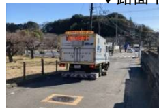
(空洞探査車による調査)
