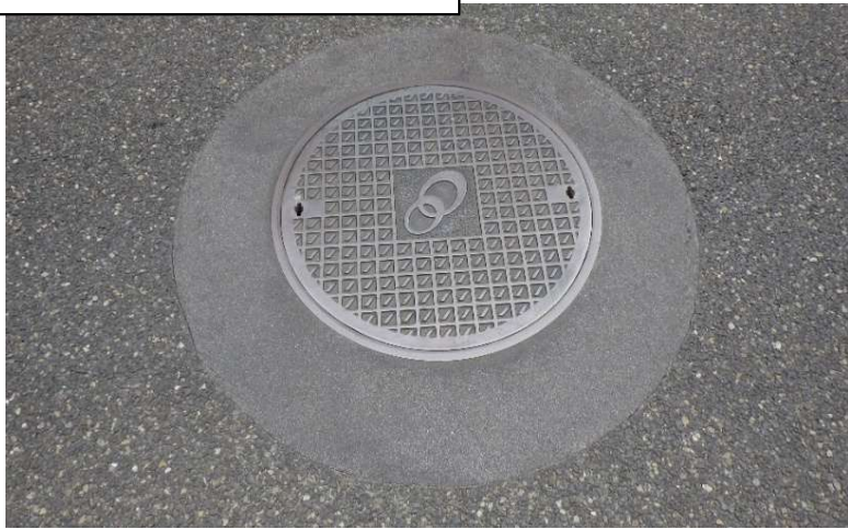
点検状況:写真②
