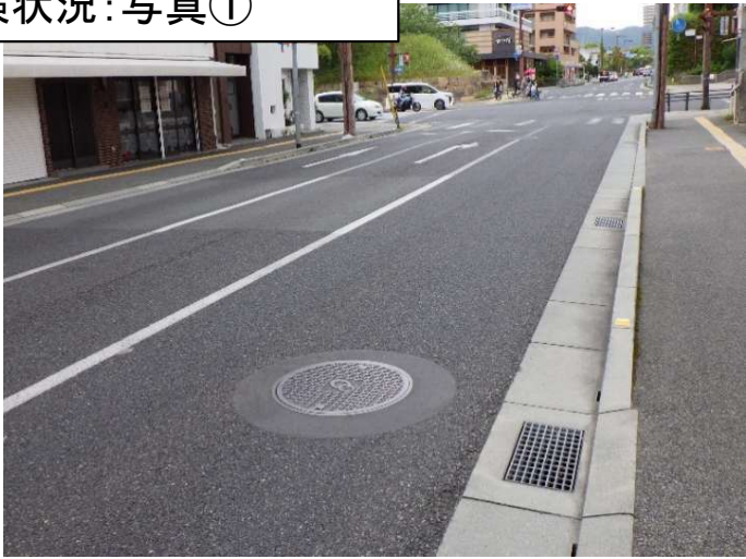
点検状況:写真①
