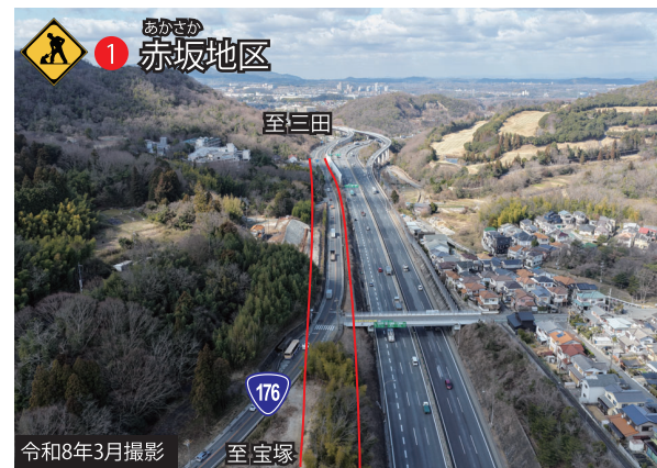
道路改良工事を行っています
