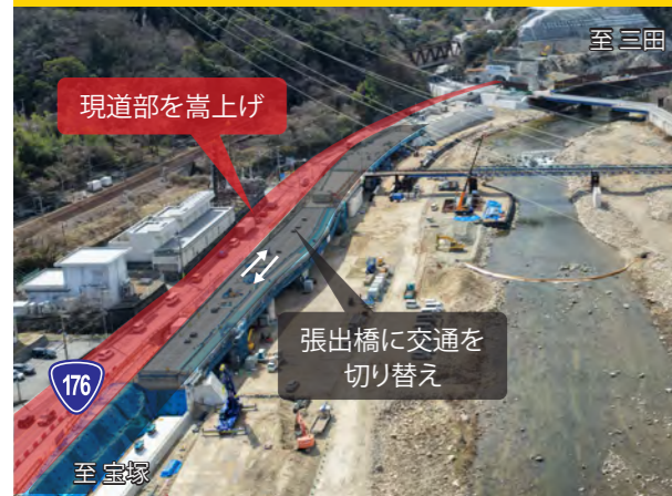
張出橋に交通を切り替えて、現道部の嵩上げ・歩道整備等の改良工事を推進します。
