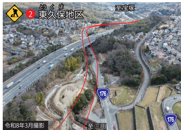
名塩川の付け替え工事を行っています。
