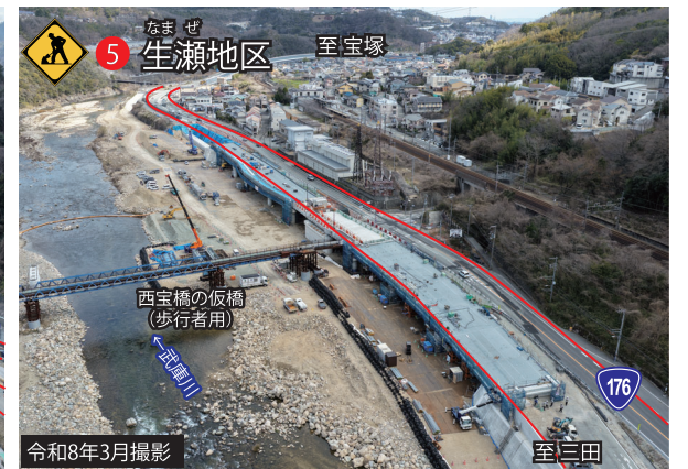
橋梁下部・上部工事を行っています。
