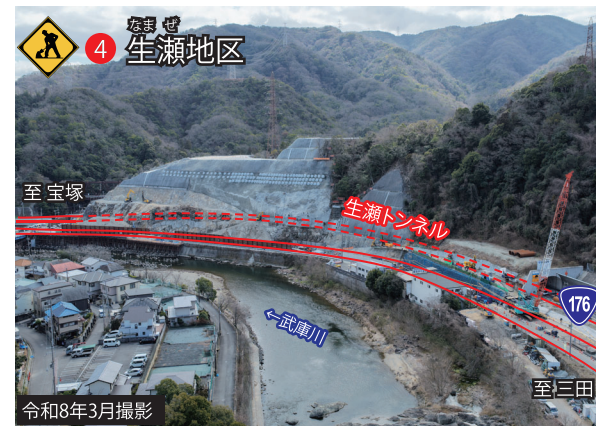
交通を生瀬トンネルに切替え、切土工事を行っています。
