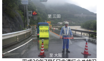
平成30年7月5日の通行止め状況
