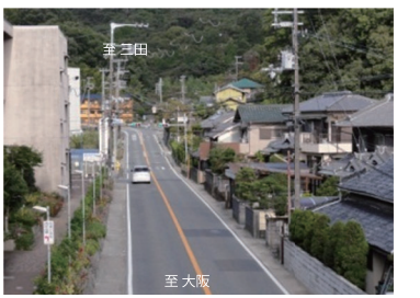
開通後 (撮影日：平成27年10月6日)
