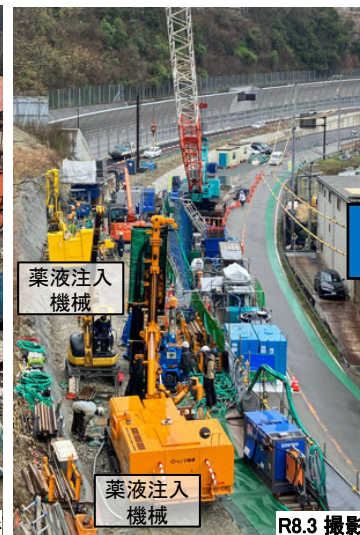
薬液注入工施工状況
