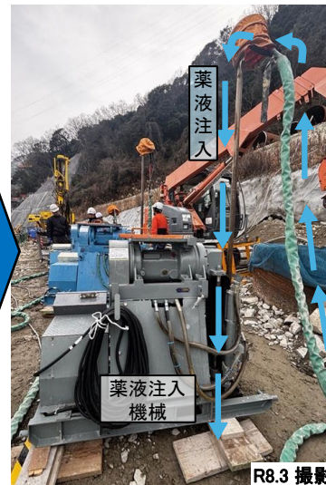
薬液注入工施工状況
