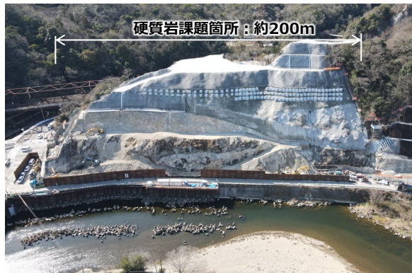
写真① 切土工・自然斜面補強工施工中
