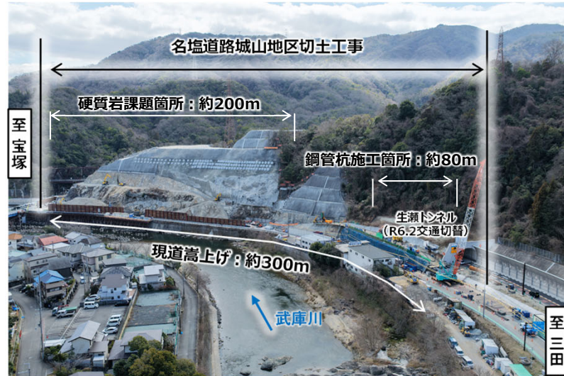
名塩道路城山地区切土工事 全景
