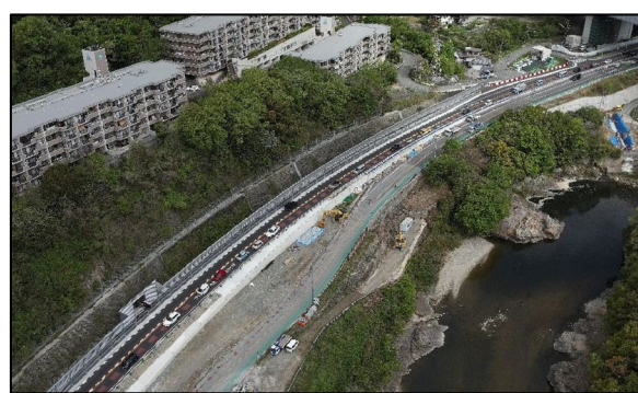
D 生瀬工区 大多田橋交差点付近
