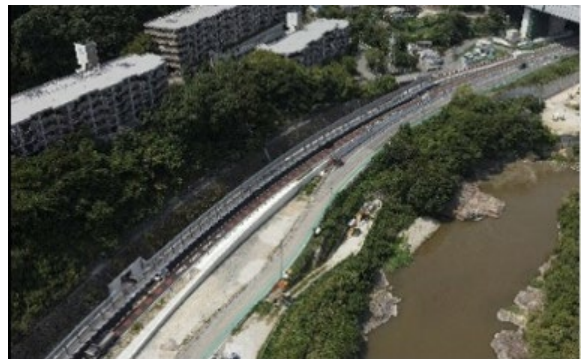
D 生瀬工区 大多田橋交差点付近
