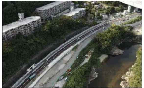
D 生瀬工区 大多田橋交差点付近
