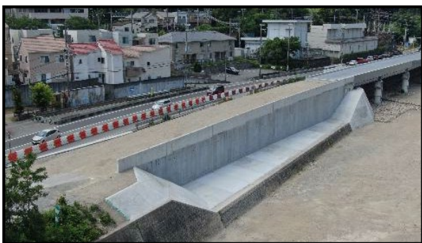
C 生瀬工区 西宝橋南詰交差点付近 L型擁壁が完成しました。
