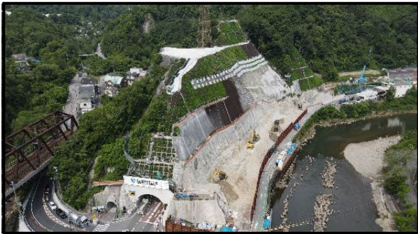
C 生瀬工区 西宝橋南詰交差点付近 L型擁壁が完成しました。
