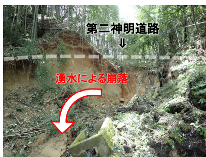
現地状況 (断層部における土砂崩落)
