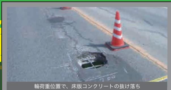
輪荷重位置で、床版コンクリートの抜け落ち
