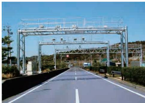
車両重量自動計測装置による計測
