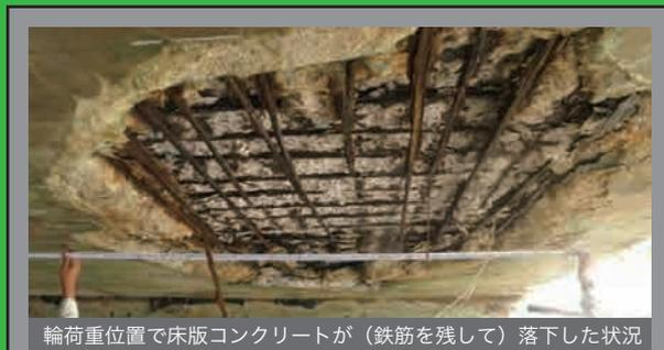
輪荷重位置で床版コンクリートが（鉄筋を残して）落下した状況
