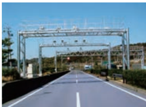
車両重量自動計測装置による計測
