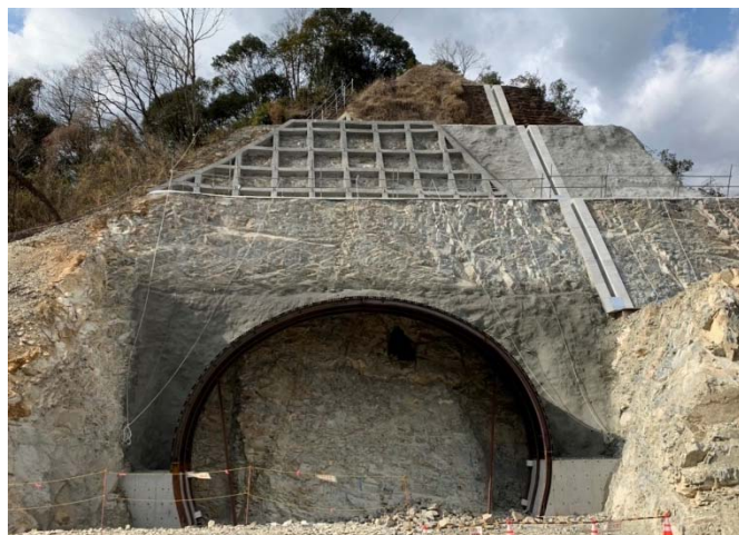
トンネル坑外貫通後(宝塚側)
