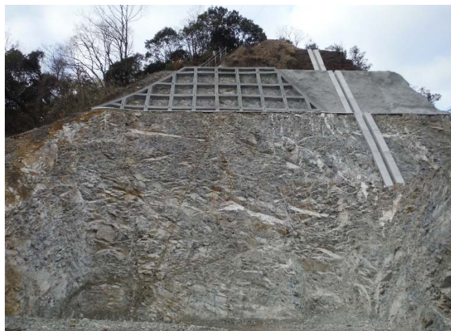
トンネル坑外貫通前(宝塚側)
