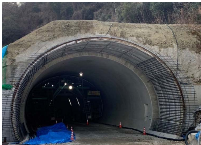
掘削後(三田側)
