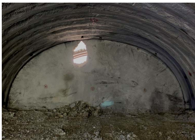
トンネル内貫通後
