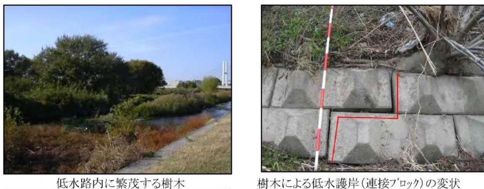
図 2.1.3 河道内樹木の繁茂および根茎による低水護岸への損傷状況
