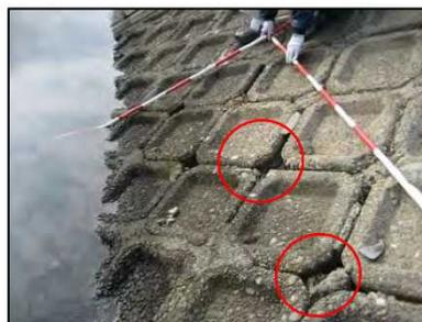
低水護岸老朽化 (目地隙間)
