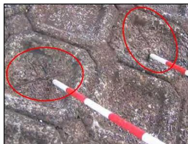
高水護岸老朽化 (鉄筋露出)
