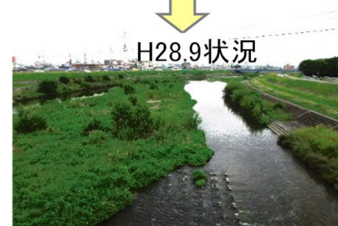
樹木伐採後の再繁茂状況写真(猪名川2.6k付近)
