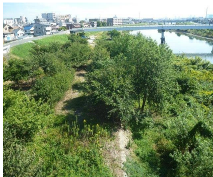
河道内に繁茂する樹木
