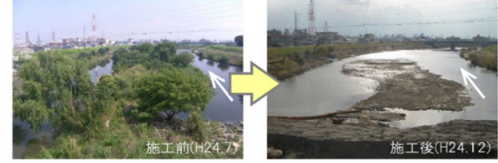
【施工前後写真(猪名川2.6k付近)】
