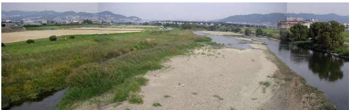
図 1.5.1 河原環境に配慮した河道掘削の状況（猪名川 8.2k 付近、北伊丹地区）
