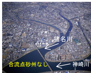
図 1.4.2 神崎川合流点状況
