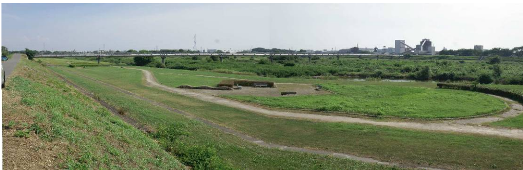
② 占地下流部(上流より)
