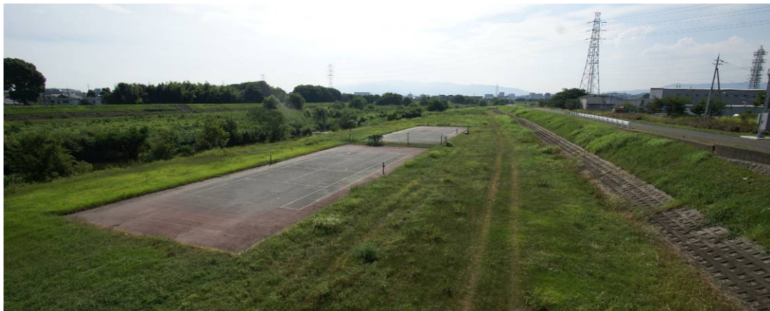
① 占用区域全景(下流端から上流をのぞむ) (左岸)
