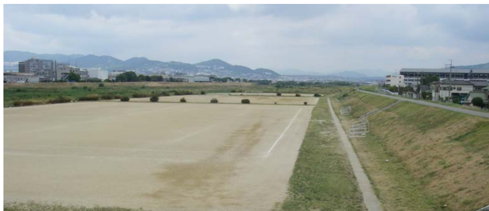
② 占用区域全景（下流端から上流を望む）
