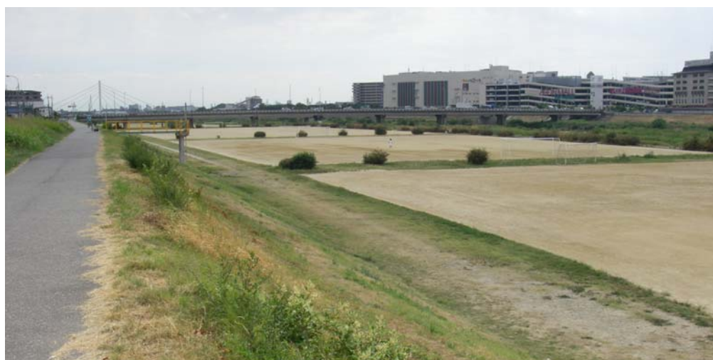
③ 占用区域全景（上流端から下流を望む）
