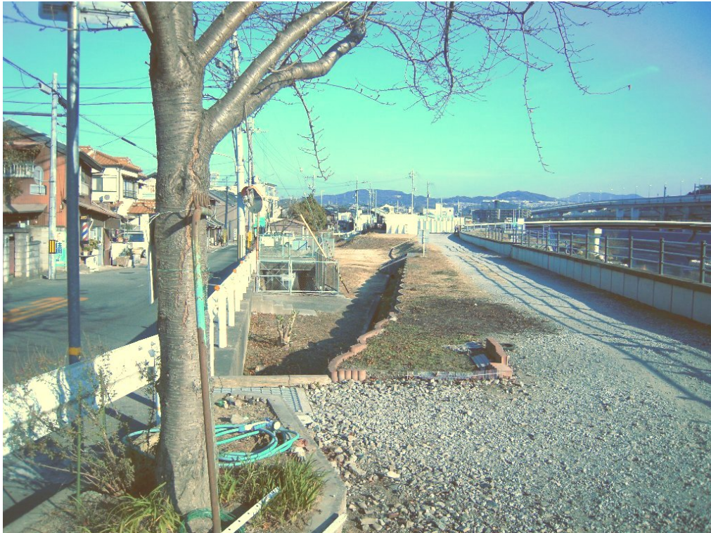
① 占用区域全景（下流端から上流を望む）
