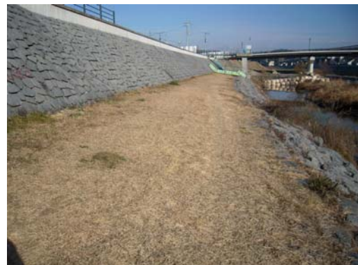
⑱堤防堤外側法面・高水敷・低水護岸
