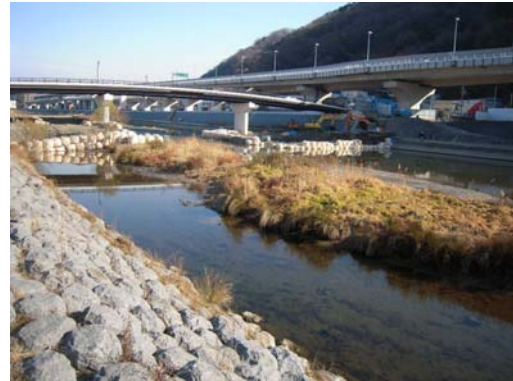
⑭絹延橋付近の工事
