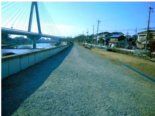
⑰堤防天端
