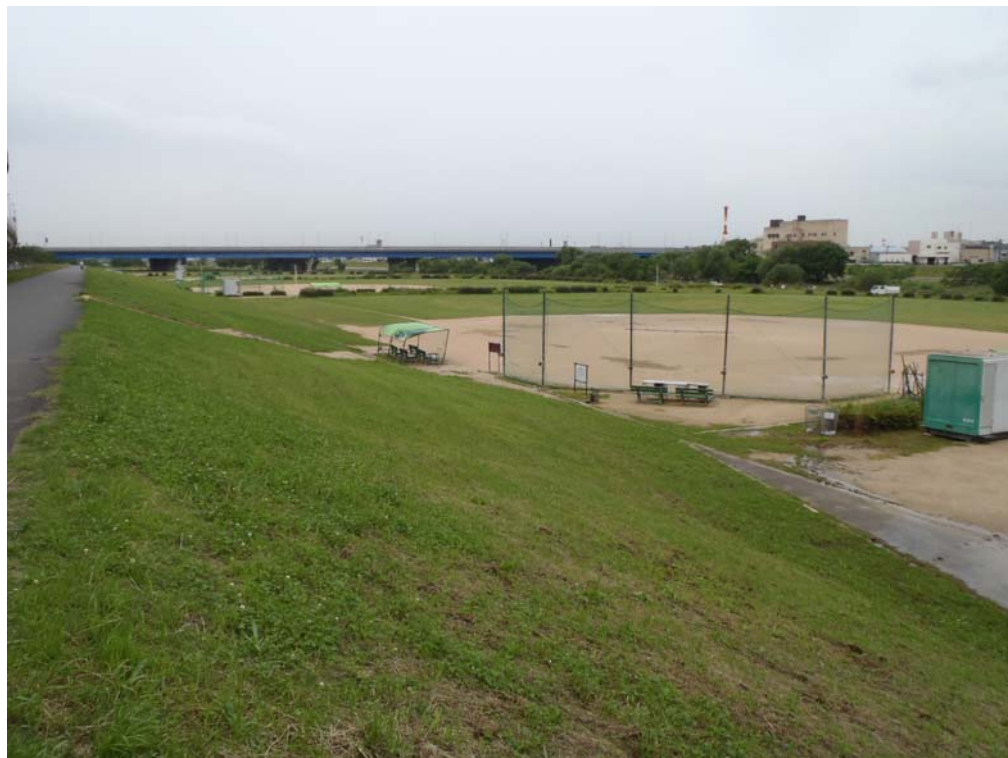
② 占用区域全景（9.6km 付近から下流を望む）
