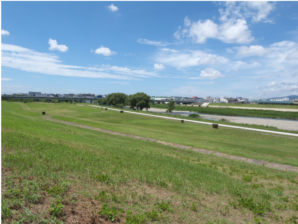
② 占用区域全景（上流端付近から下流を望む）
