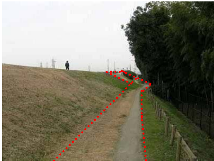
上流部から下流部を望む
