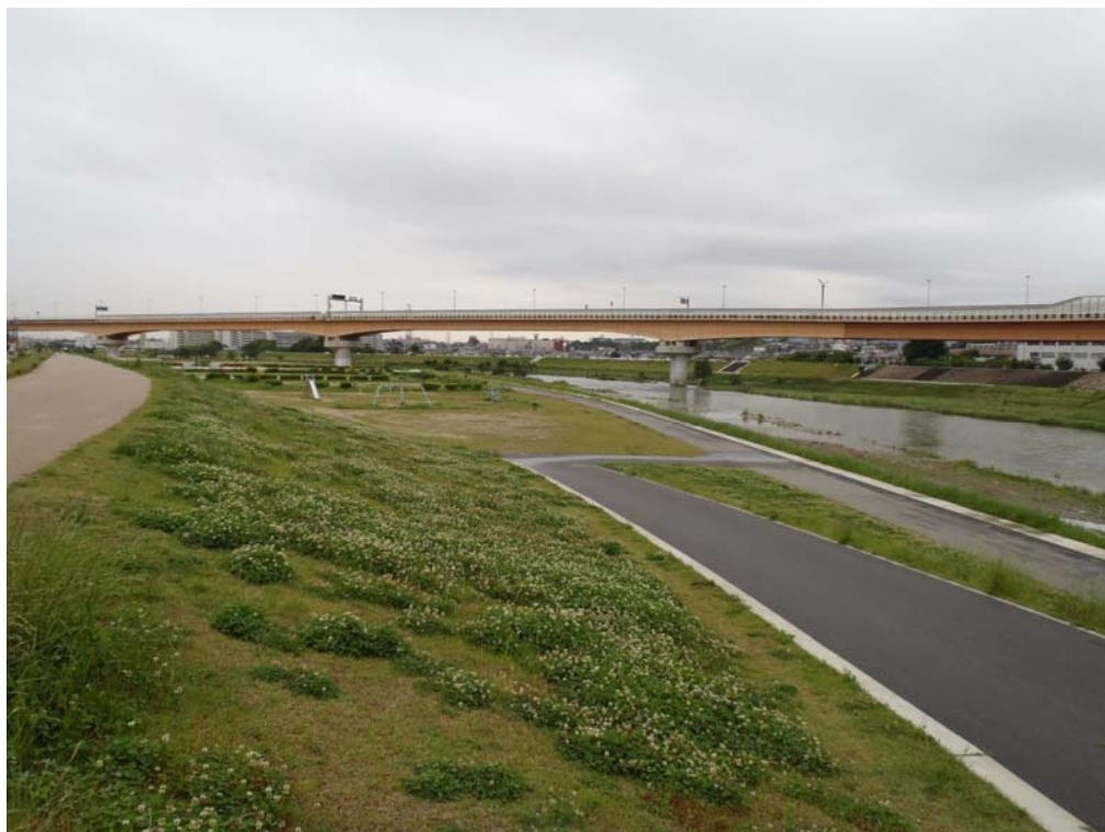
④ 占用区域全景（上流端付近から下流を望む）
