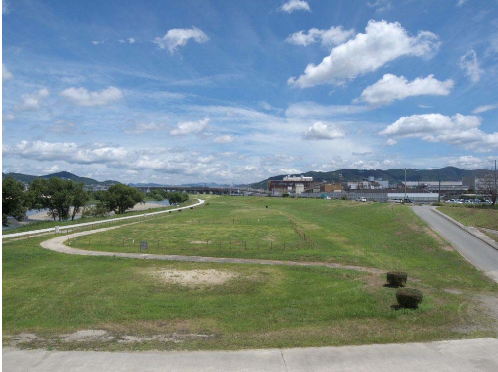
① 占用区域全景（下流端付近から上流を望む）
