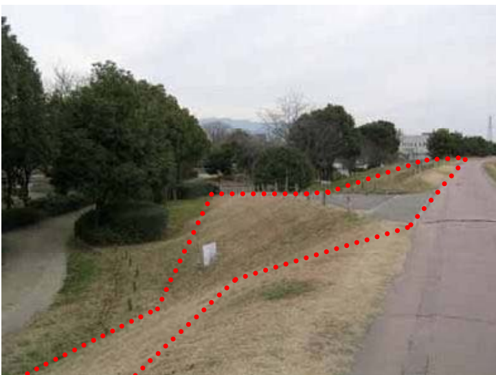
下流部から上流部を望む
