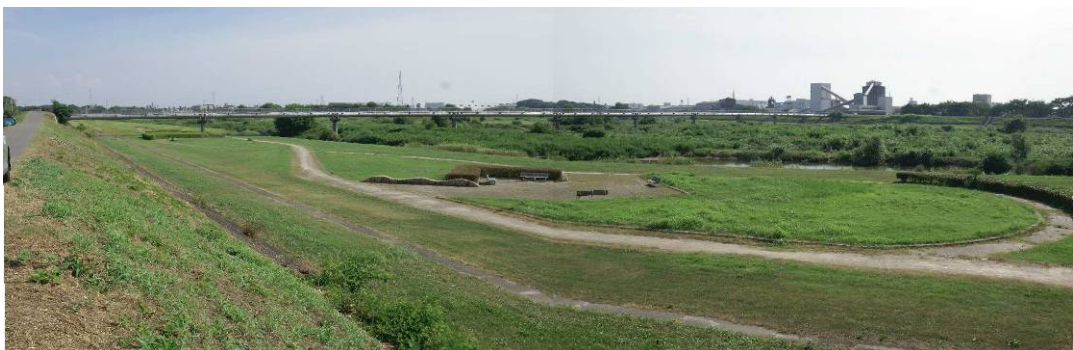
② 占地下流部(上流より)
