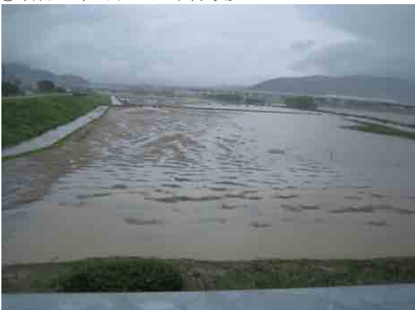
③平成 26 年 8 月 10 日 出水状況
