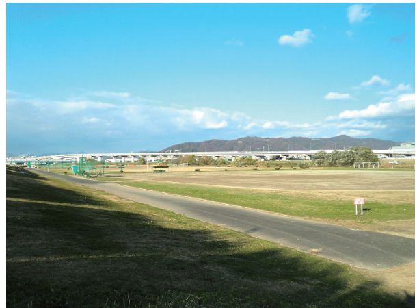
② 占用区域全景(下流から上流を望む)
