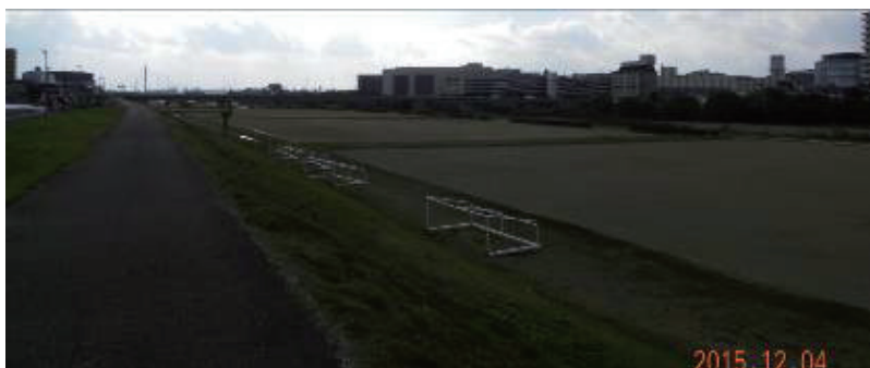
③ 占用区域全景(上流端から下流を望む)
