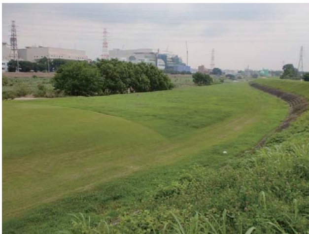
① 占用区域全景(上流から下流を望む)(右岸)
