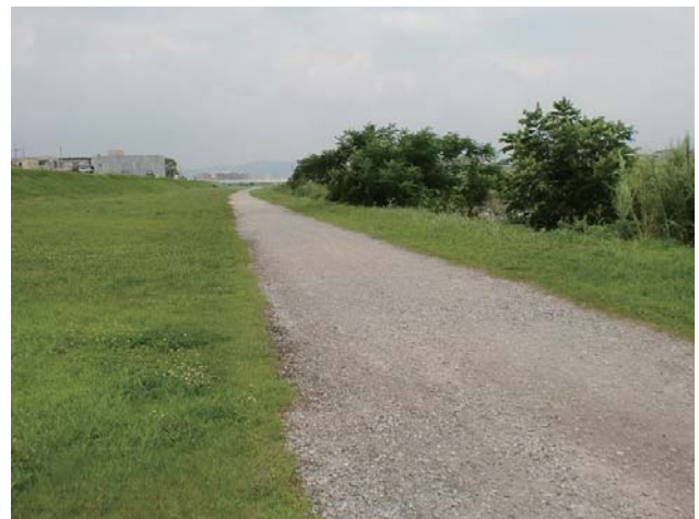
② 占用区域全景(下流から上流を望む)(右岸)
