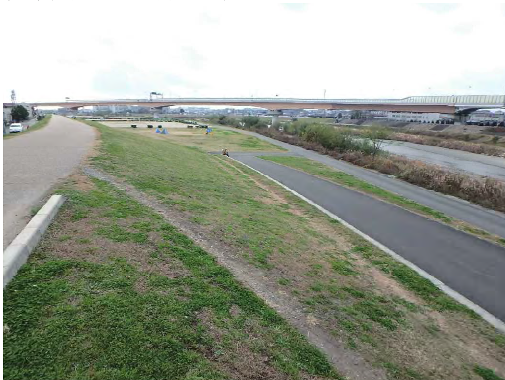
④ 占用区域全域(上流端付近から下流を望む)
