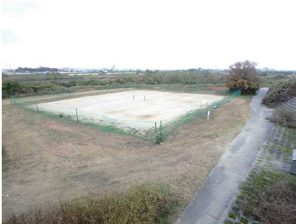
② 占用区域全域(上流端付近から下流を望む)
