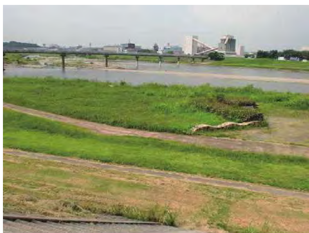
① 占用区域全景(上流から下流を望む)(左岸)
