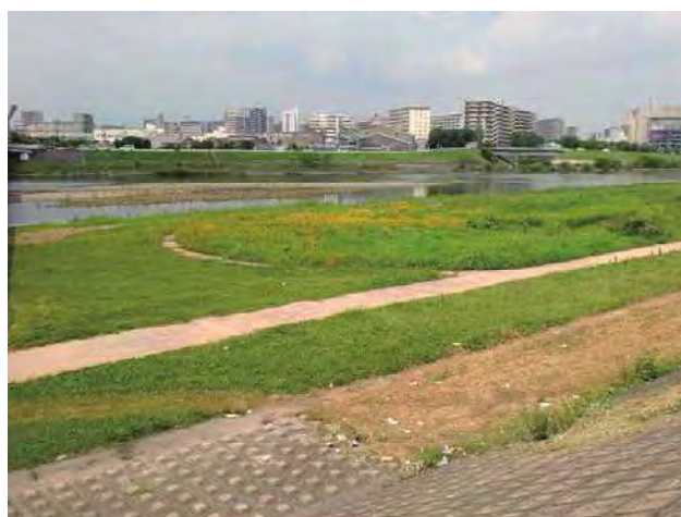
② 占用区域全景(下流から上流を望む)(左岸)
