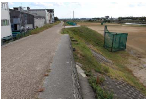
堤防側の状況
