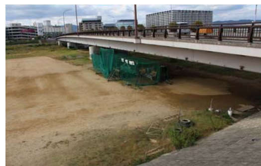
桑津橋下の状況
